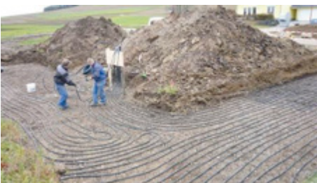
Abb. Zeigt die Montage eines Erdkollektor (Erdwärmesystem)
